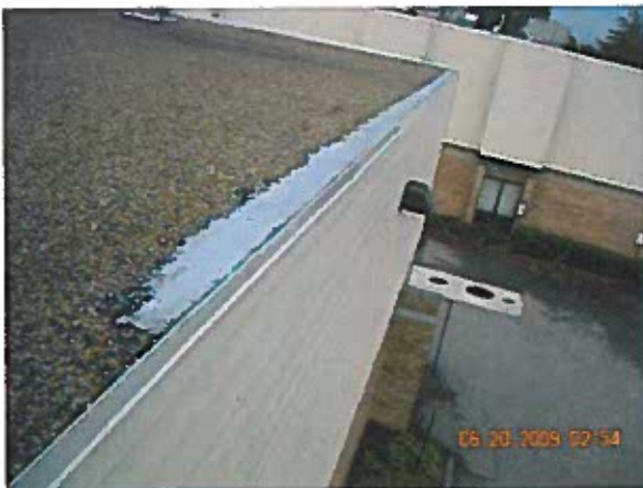
Area 1—Observation Perimeter edge metal
