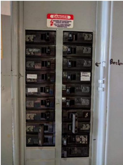
Existing Penthouse PP3
